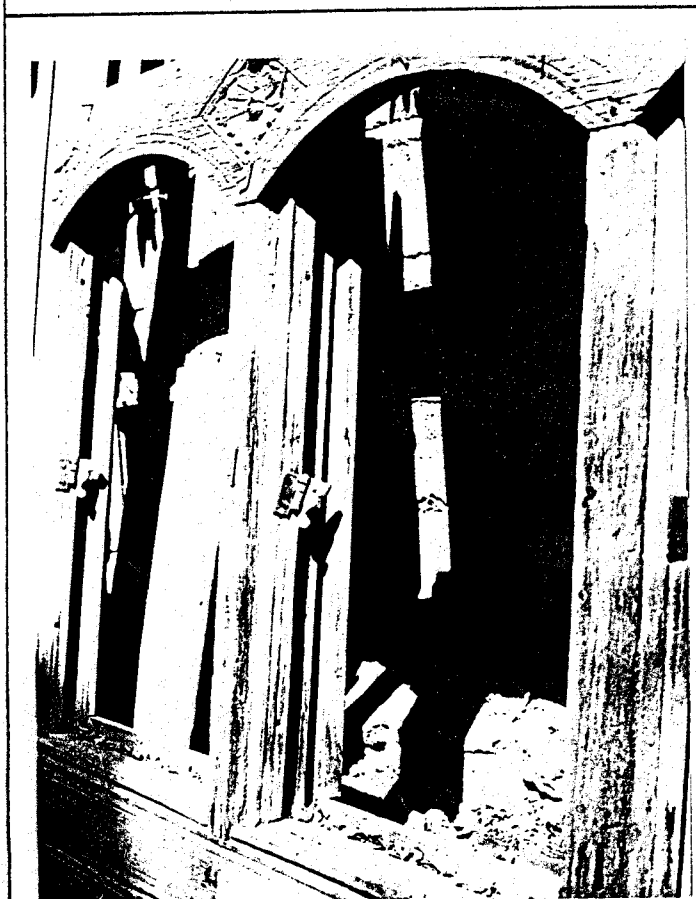
صورة توضح سلك الخشب الذي ينزلوه عليه الضلف السحاب والقلمب
